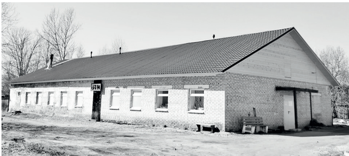
► У бани отремонтированы фасад и крыша
