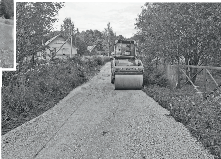
► Обсыпка и грейдерование дороги в Усланке
