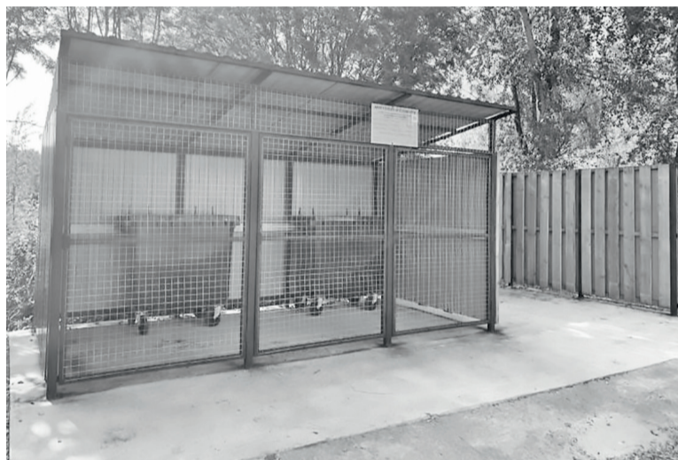
► Новая контейнерная площадка на улице Школьной
